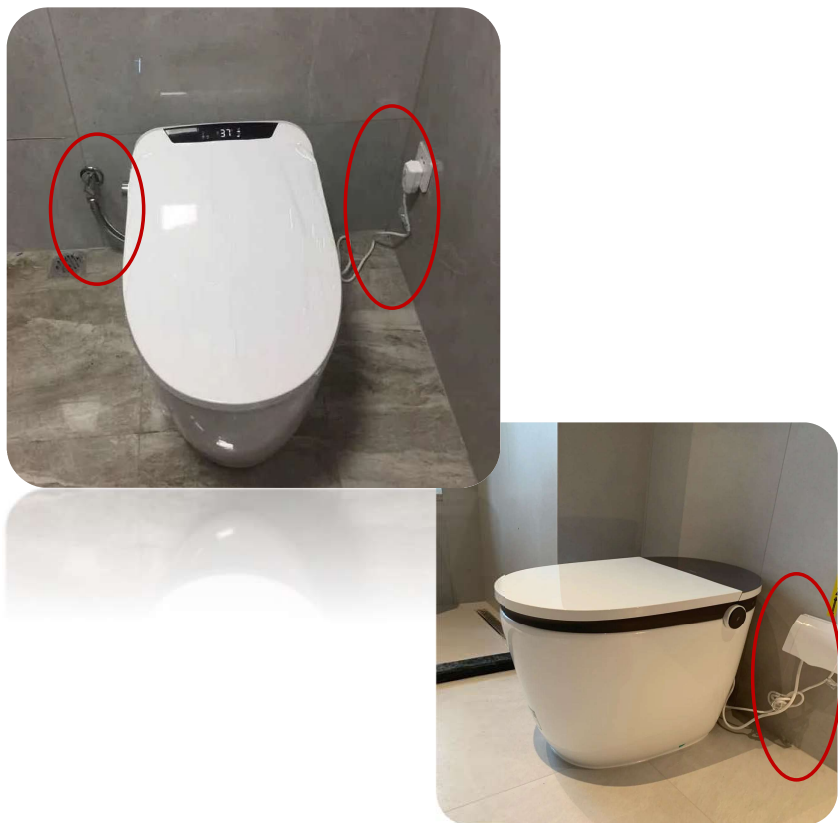
Competitor floor standing shower toilet Sản phẩm toilet thông minh trên thị trường Expose wiring and water supply Dây điện và đường nước lộ thiên
